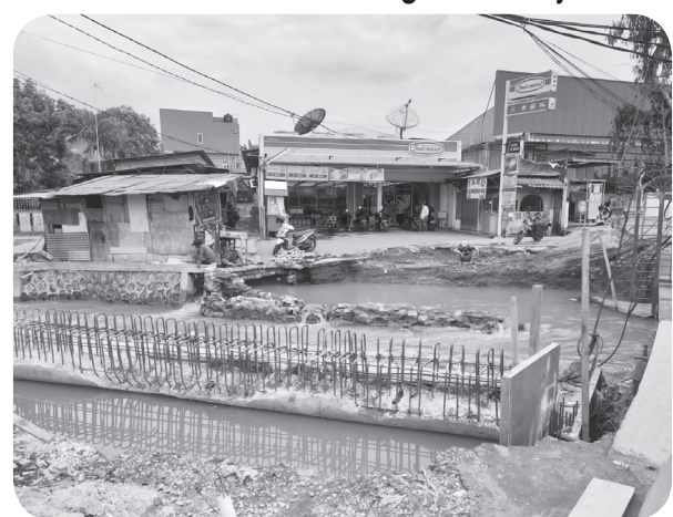
Pekerjaan Jembatan Kali Pete, Mustikajaya, Kota Bekasi, Sabtu (8/10).
